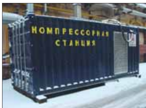
Станция на базе блок-бкса с габаритами 20-ти футового контейнера
