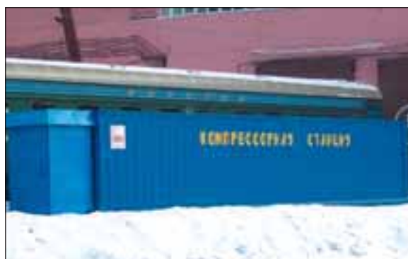
Станция на базе блок-бкса с габаритами 40-ка футового контейнера
